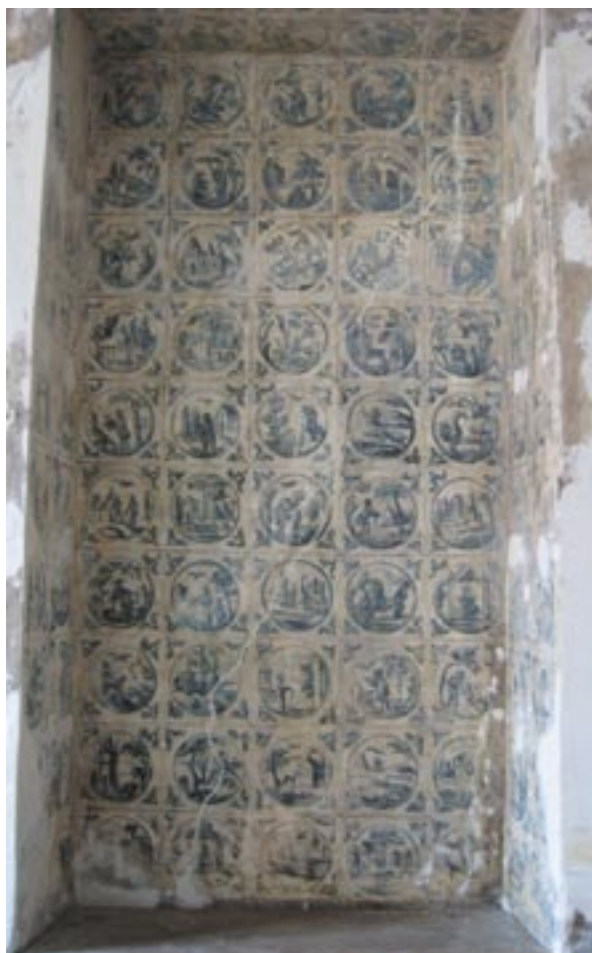
Pracovní snímek, stav po vytmelení defektů
