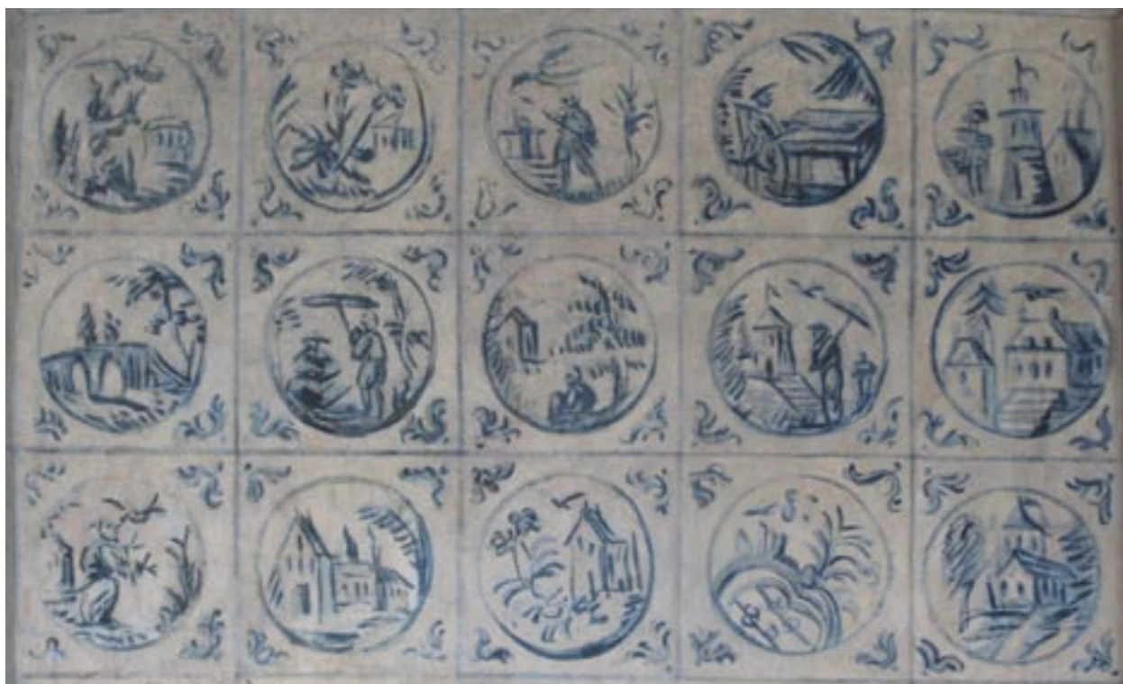
Stav po restaurování, detail horní části
