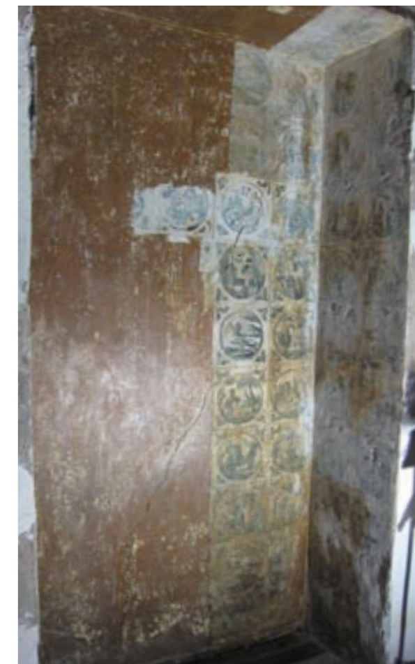
Pracovní snímek, postup odstraňování nitrocel. nátěrů
