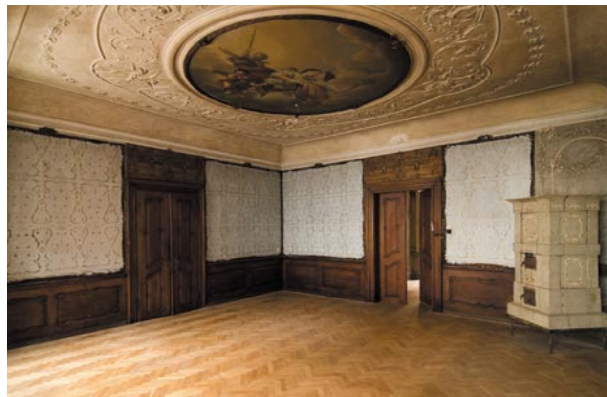
Stav před restaurováním, pohled JZ
