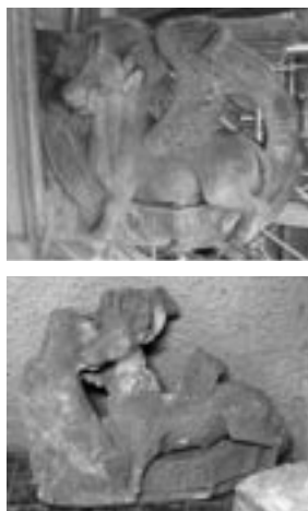
Obr. č. 2: Srovnání sochařských prvků z Chrámu sv. Barbory nahore: prvek z 19. století – hořický pískovec dole: prvek z 16. století – kutnohorský vápenc
