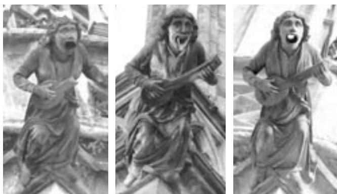
Obr. č. 2: Srovnání sochařských prvků z Chrámu sv. Barbory nahore: prvek z 19. století – hořický pískovec dole: prvek z 16. století – kutnohorský vápenc
