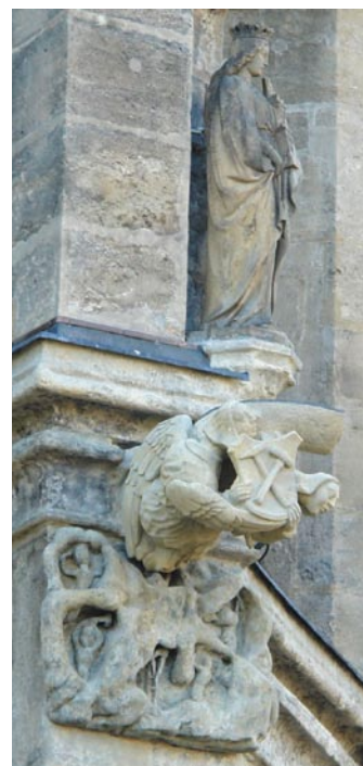
6. Nový chrlič po osazení na Chrám
