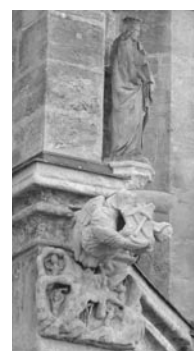
6. Nový chrlič po osazení na Chrám
