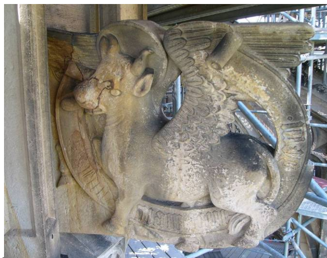
Obr.č.2 - prvek z 19. století z hořického pískovce
