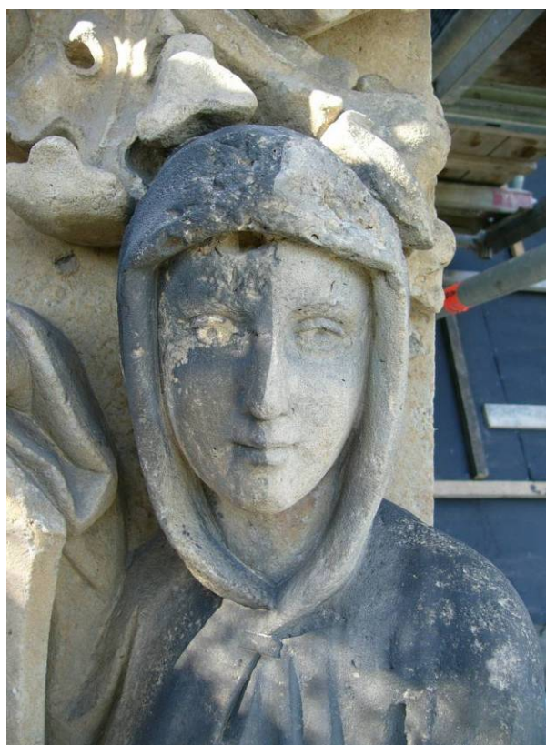
Obr. č.4 – průběh čištění mikrotryskáváním
