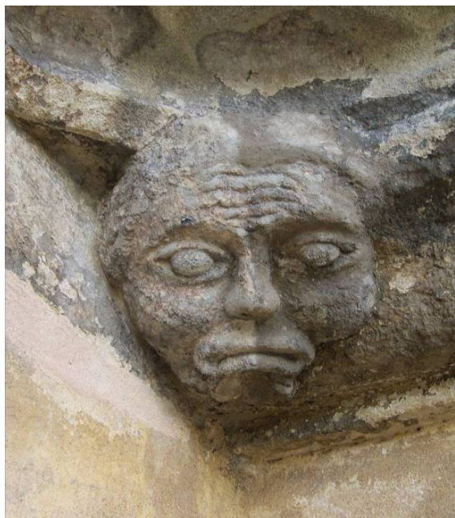
Obr. č.3 – průběh čištění mikrootryskáváním
