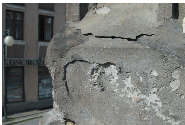
Stav před restaurováním, 2010 – rozpad kamene pod tmely
